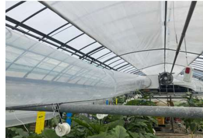
冷・温風扇は単管で頭上設置
