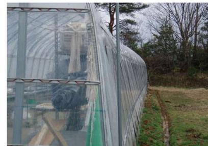
一部の骨材の変形に伴い、ハウス全体にゆがみが発生
